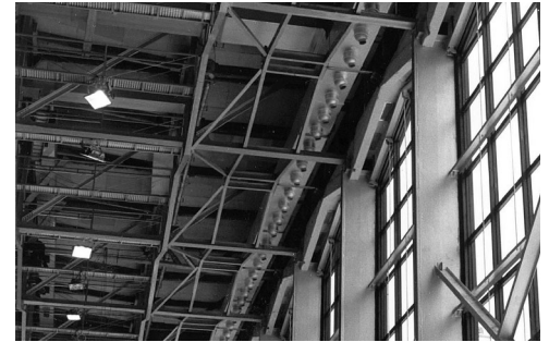
Klimatizacija bazena u SRC „Tašmajdan”
