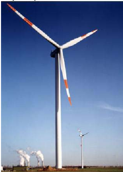
Slika 1. Prototip vetrogeneratora prečnika rotora 80m, instalisane snage 2.5MW
