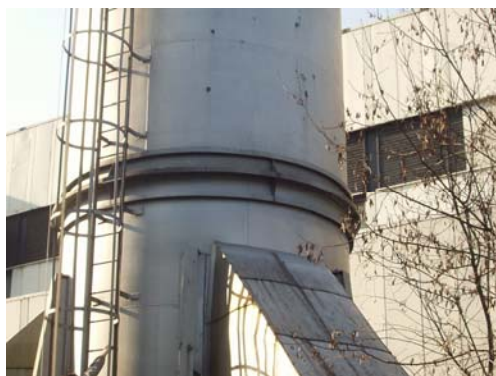
Slika 1. Segment dimnjaka sa dimovodnim kanalom
