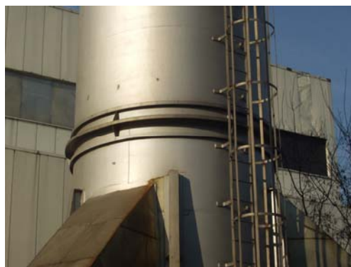
Slika 1. Segment dimnjaka sa dimovodnim kanalom
