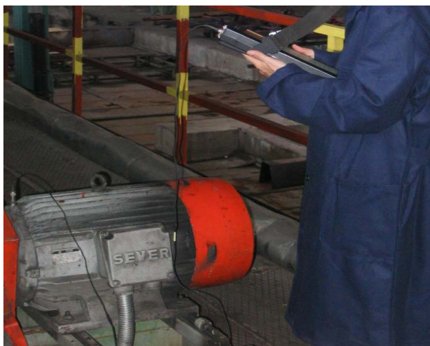
Slika 2. Ispitivanje vibromehaničkog stanja asinhronog motora u pogonu
