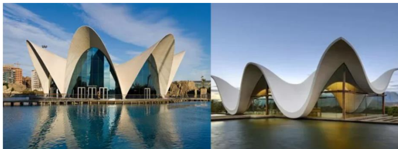
Slika 1.4 – Lančane krive u konstrukcijama Feliksa Kandelega
