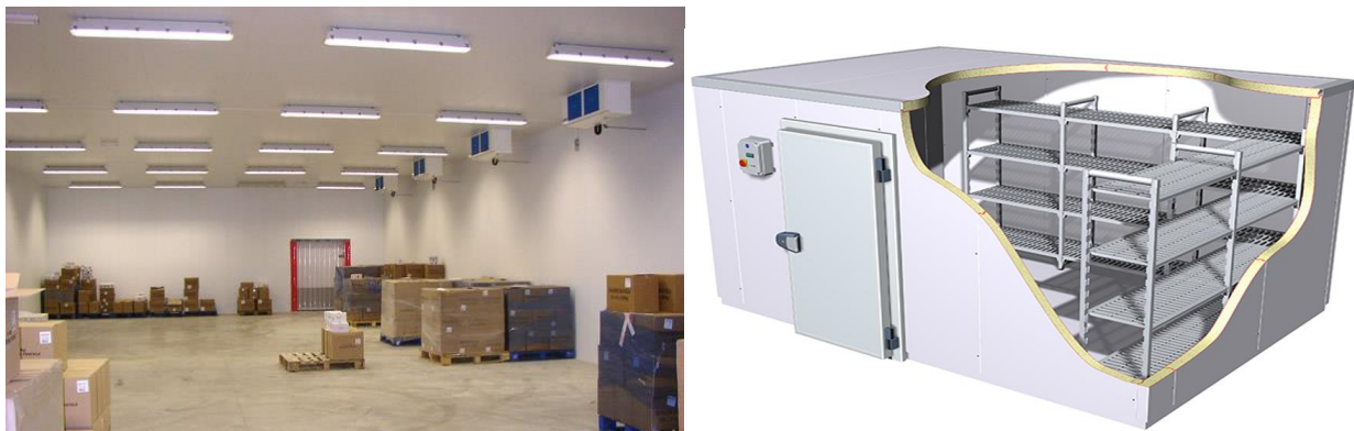
Слика 10. Илустрација изгледа унутрашњости велике расхладне коморе за смештај упакованих производа (лево) и мале расхладне коморе (десно)
